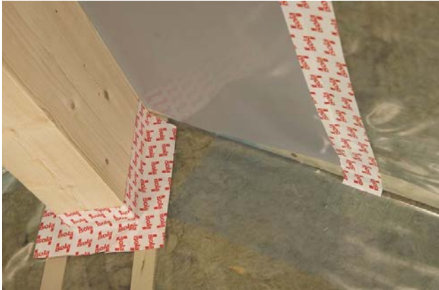
Fig. 8 Eksempel på bruk av Isola FLEX Dampsperrer Tape for tetting rundt bjelkegjennomføring.
