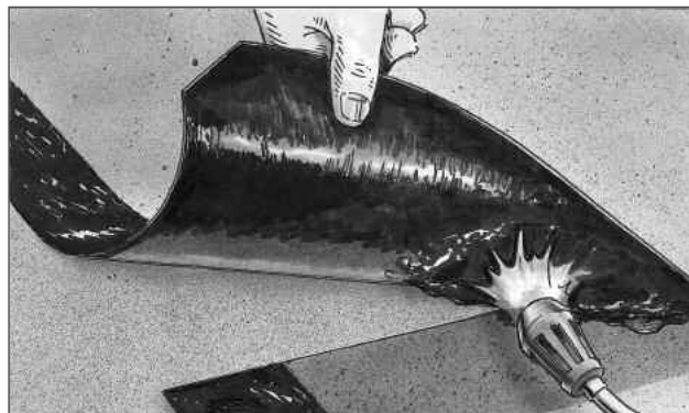
Ved endeomlegg skrånkjæres sidekanten
