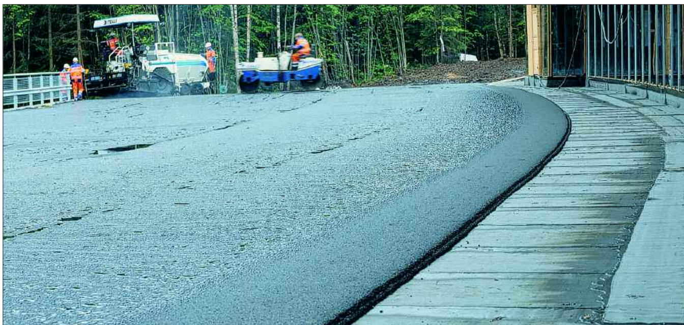
Parkeringsdekke med veiasfalt lagt direkte på Isola Sveisemembran
