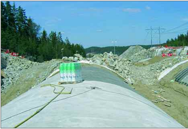
Betongbue, miljøtunnel, 4 felts motorvei
