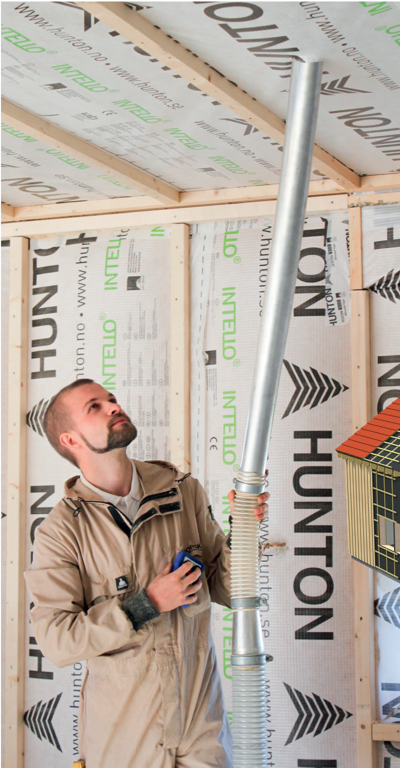
Illustrasjonen viser vegg blåseisoleret med Nativo Trefiberisolasjon.
