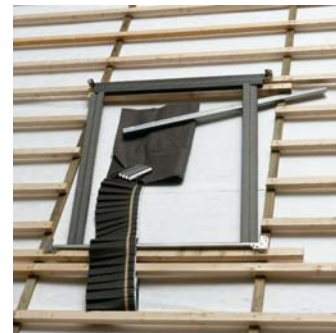
BDX 2000 karmisoleringsramme m/ undertakskrave og avvanningsrenne
