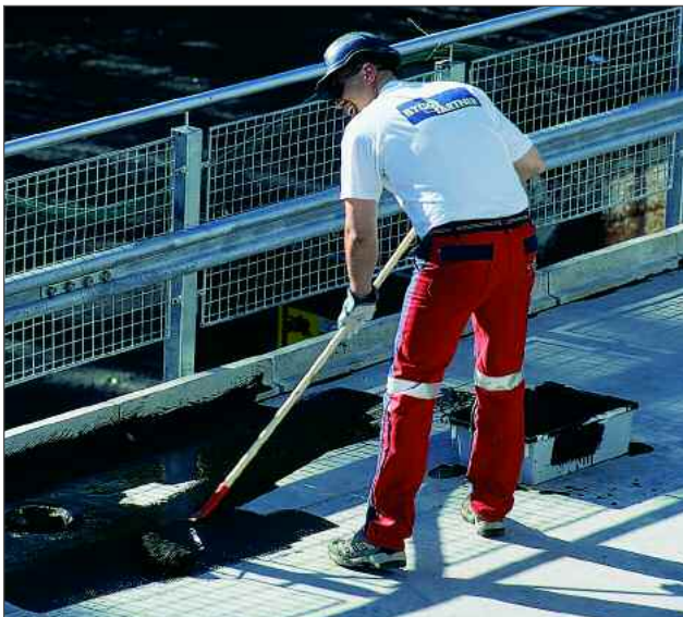
Isola Primer binder betongoverflaten og gir sikker og varig vedheft
